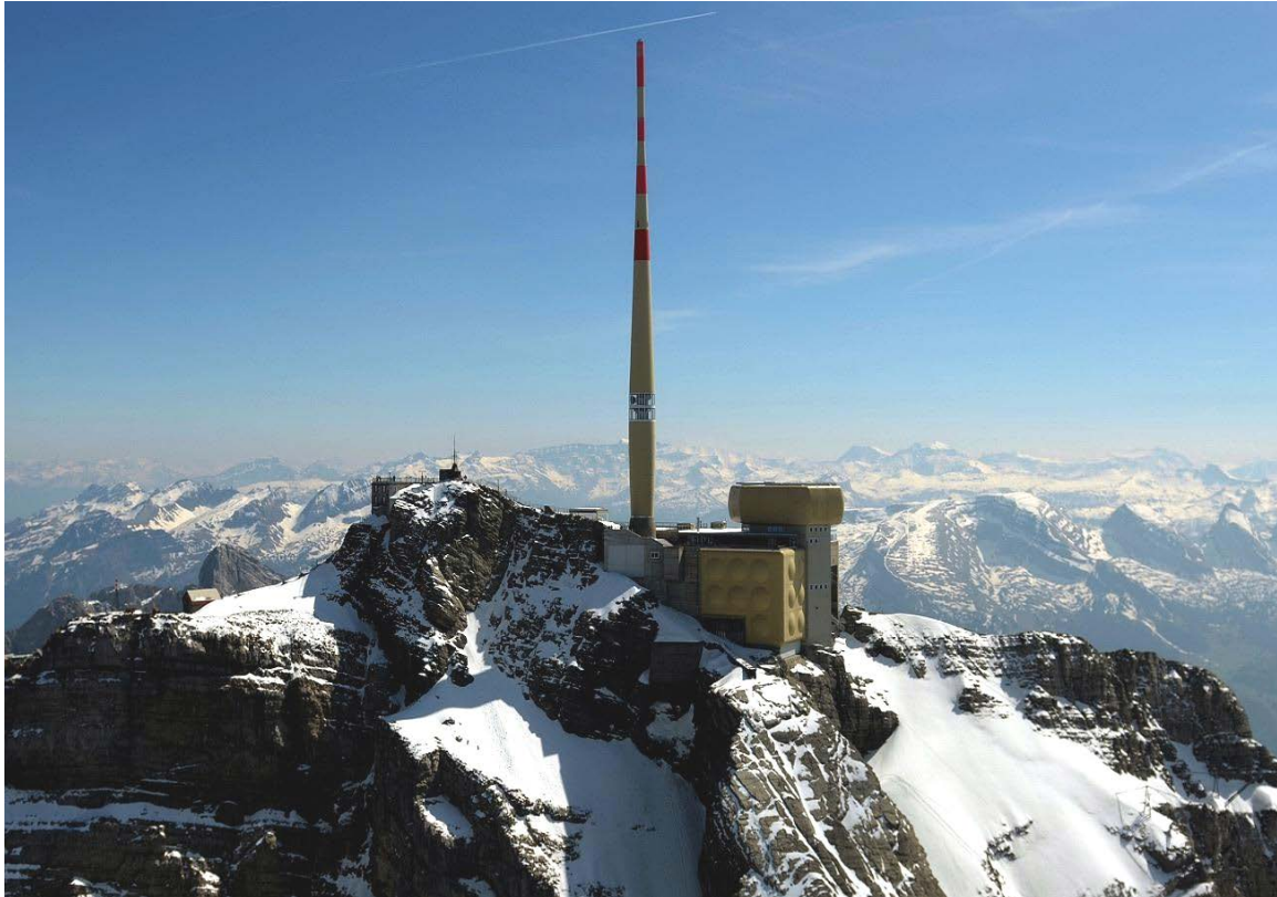
Figure 3.4. The Säntis Tower
