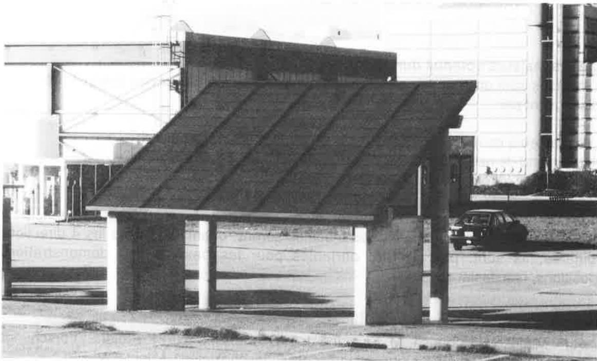
Bardeaux photovoltaïques. Ce système de couverture est le fruit d'une collaboration entre United Solar Systems Corporation et le LESO-PB.
