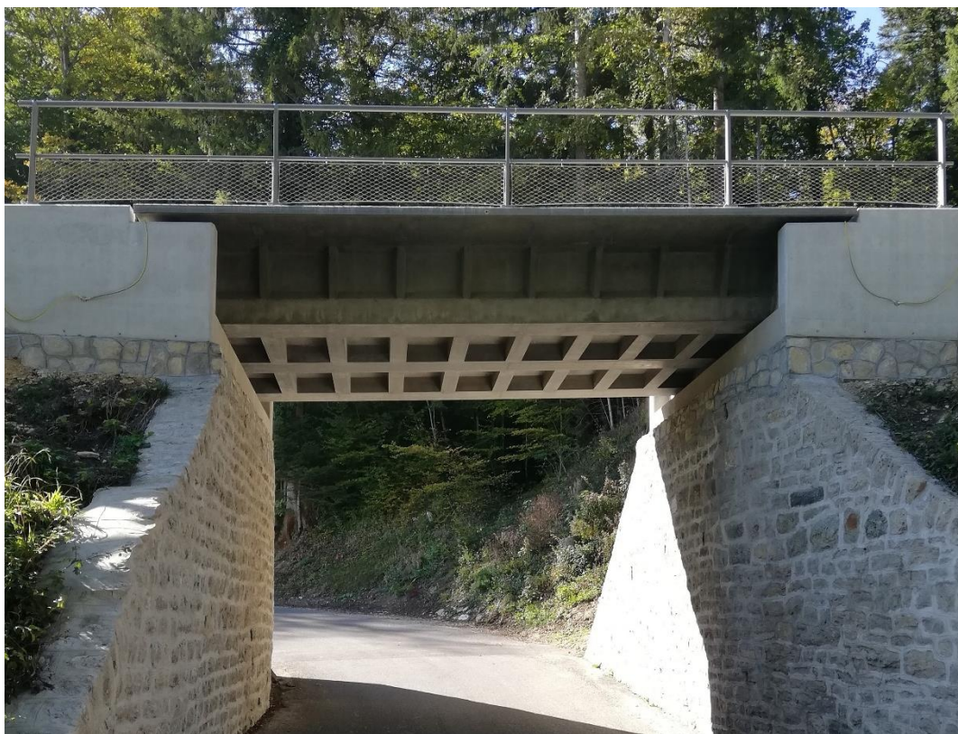
Figure 1. Le nouveau pont ferroviaire Aiguillon en CFUP armé
