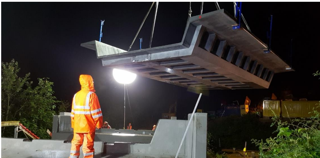
Figure 9. Pose du nouveau tablier pendant travaux de nuit
