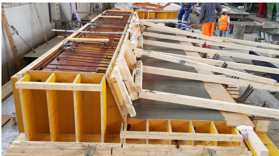
Figure 7. Fabrication d'un élément du tablier en CFUP en usine
