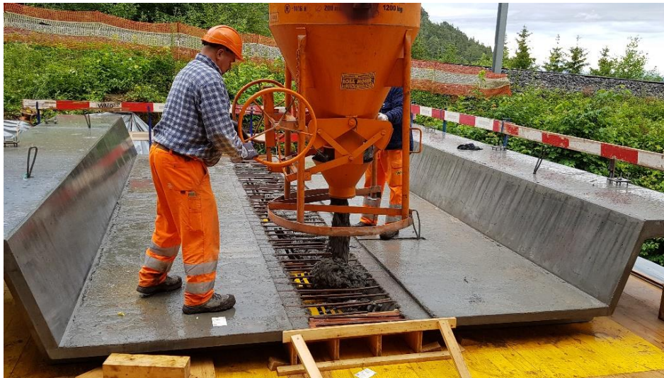
Figure 8. Clavetage de deux éléments préfabriqués du tablier par le CFUP coulé sur place
