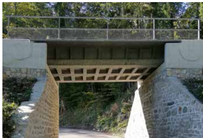
A Le nouveau pont ferroviaire de l'Aiguillon, réalisé en CFUP armé (GRUNER)
