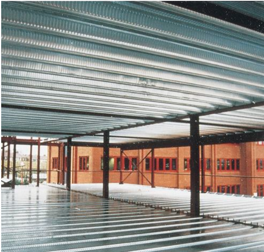
FIGURE 32 – Exemple de plancher mixte usuel
