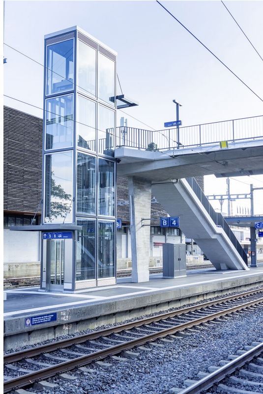
FIGURE 19 – Exemple de cage d'ascenseur à Thalwil
